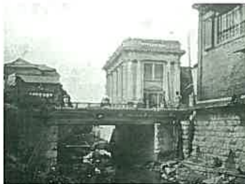
大正 11 年 配管工事中の宮益橋 （『施工中にある渋谷町水道』より）
