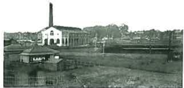
下渋谷の火力発電所（現在の渋谷区東3丁目）
