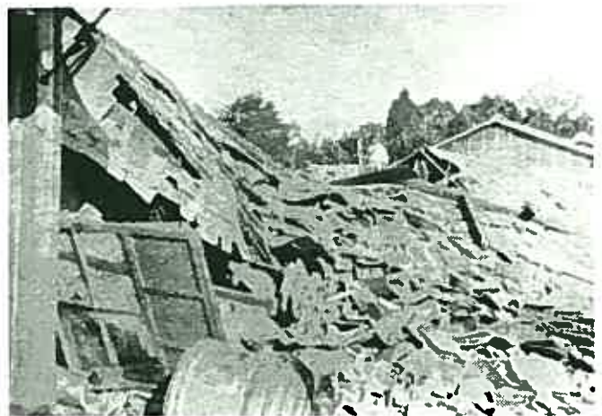
震災で倒壊した家屋(笹塚付近)
